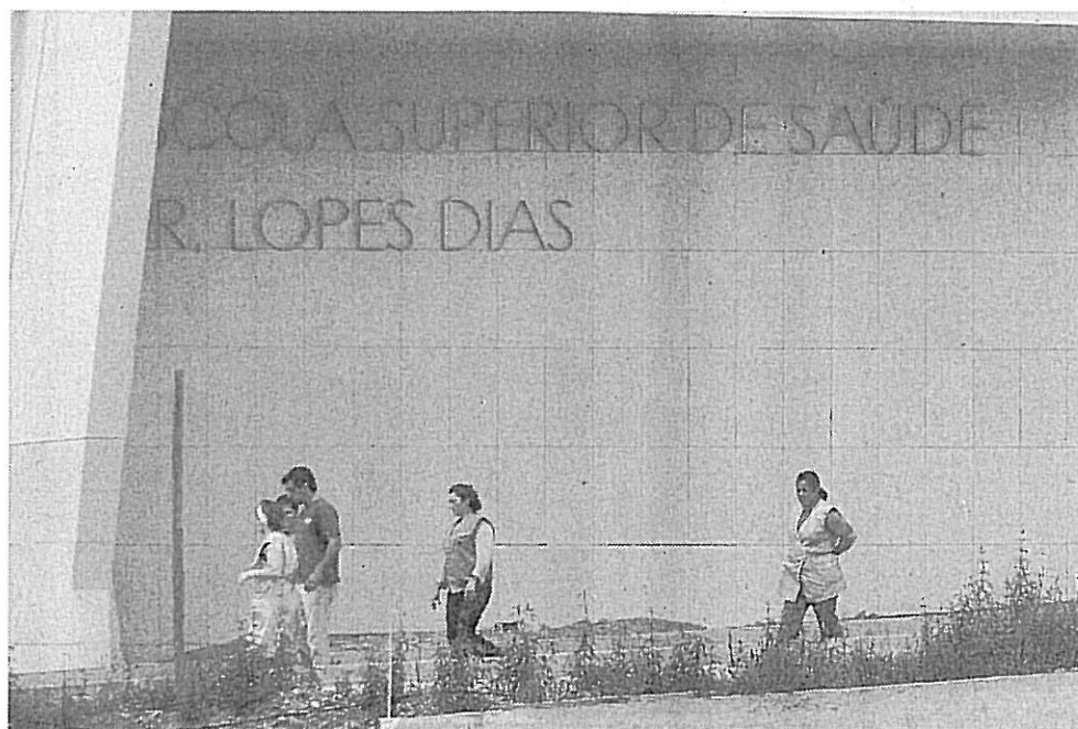
Na Talagueira já começaram os trabalhos de limpeza do edifício
